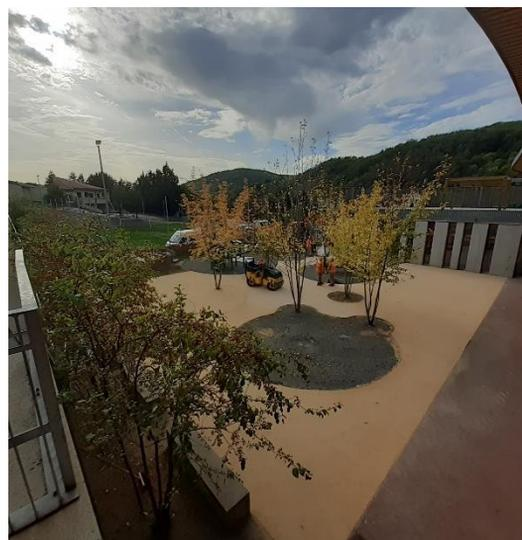
Rénovation de la cour d'école avec un revêtement innovant, sol dur mais perméable, permettant l'évacuation des eaux pluviales par infiltration. En ce qui concerne les zones de jeux, des revêtements souples et colorés
